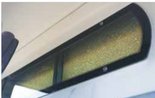
Velké kontrolní okno v kabině
